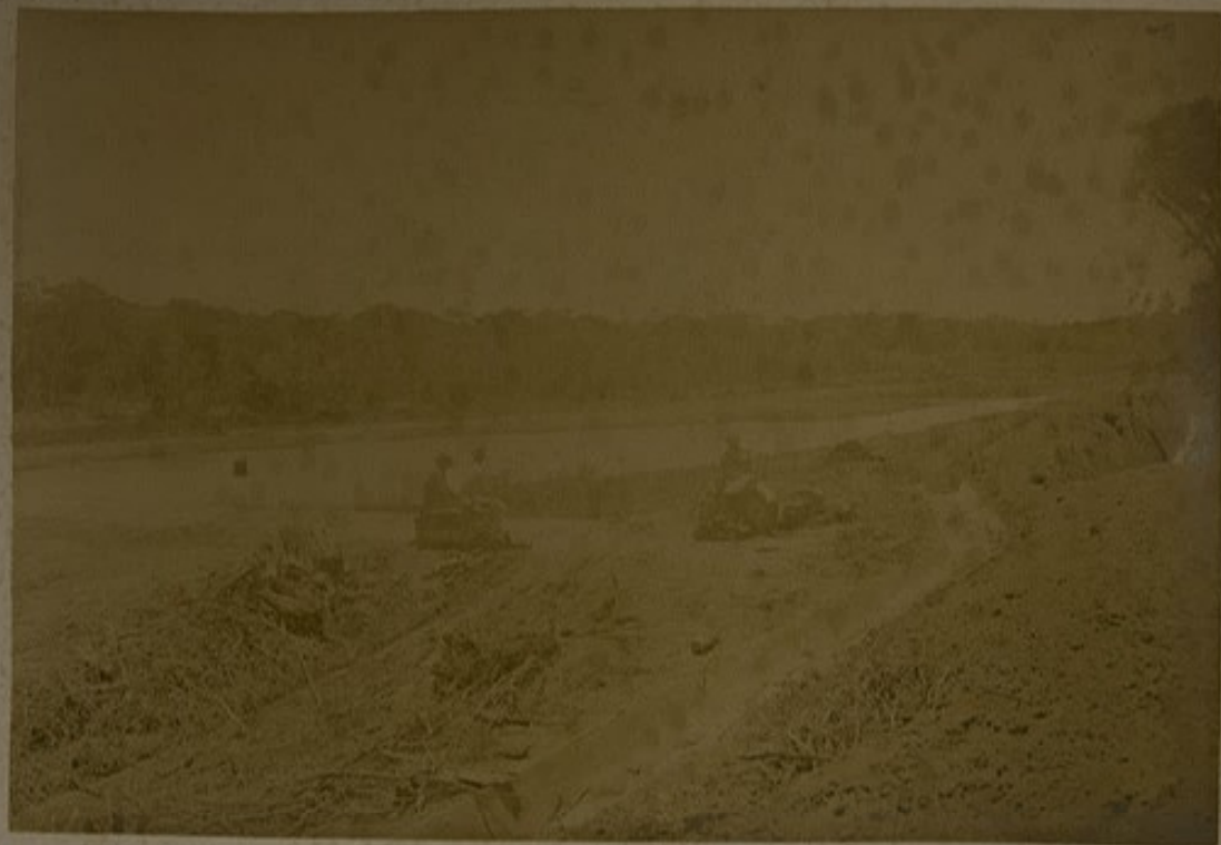
CANALIZAÇÃO DO YPRANGA — REPRESA DO CORREGO DO SORÃO
