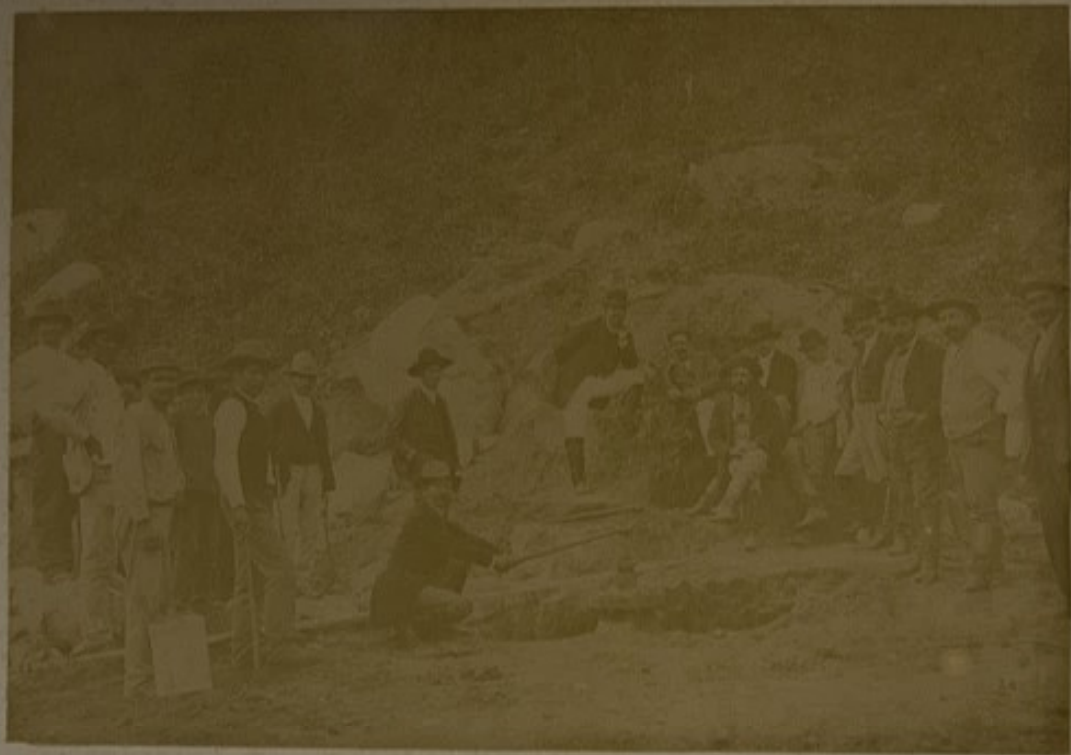
ABERTURA DO REGISTRO PARA A EXPERIENCIA DO ENCANAMENTO DE 6.4. 03
