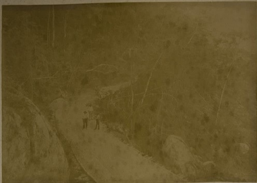
ESTRADA DE SERVIÇO ENTRE MATUCOS E ITAGUASSU
