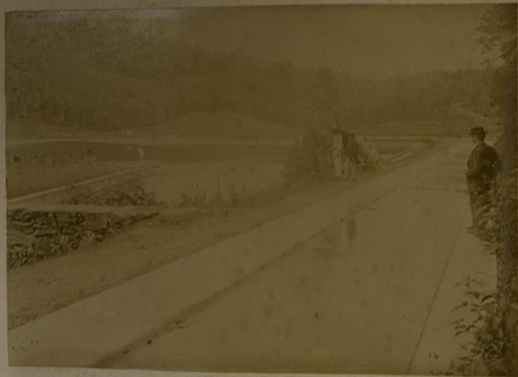
RESERVATÓRIO N. DE ACCUMULAÇÃO
