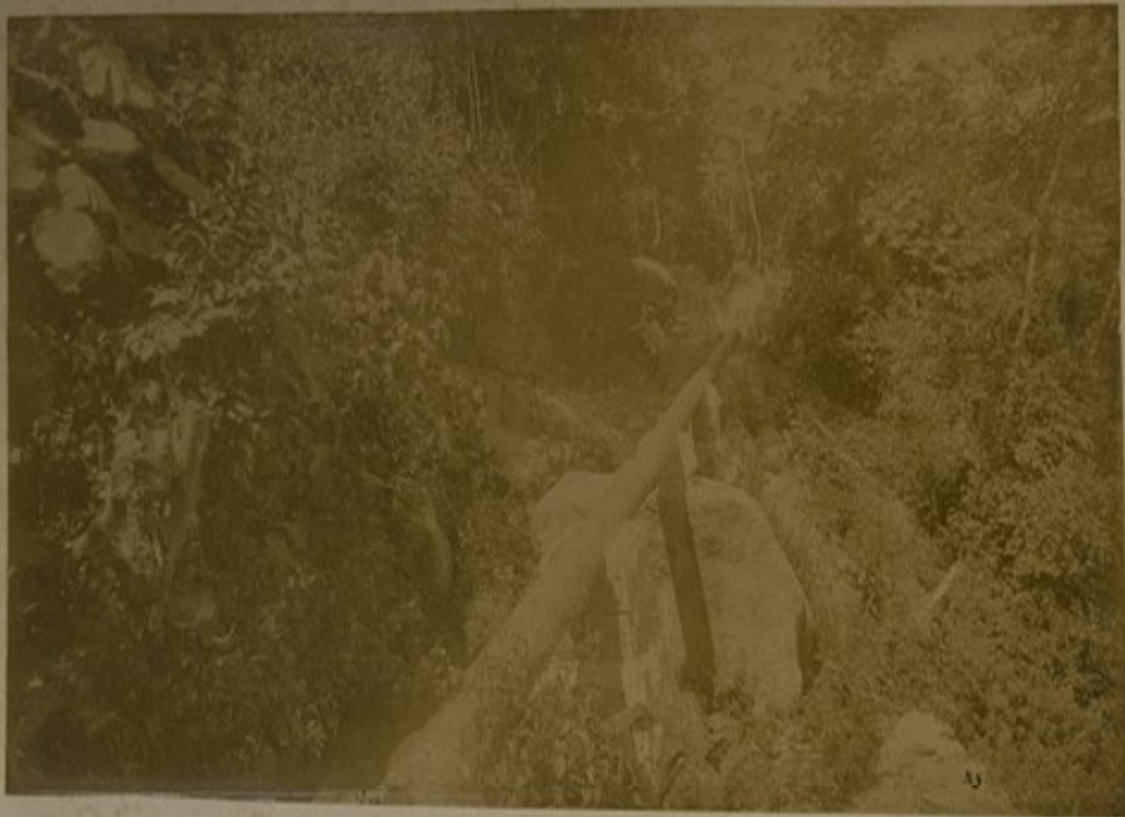
ENCARAMENTO DO CASERUNGA PARA O RESERVATÓRIO DE ACCUMULAÇÃO
