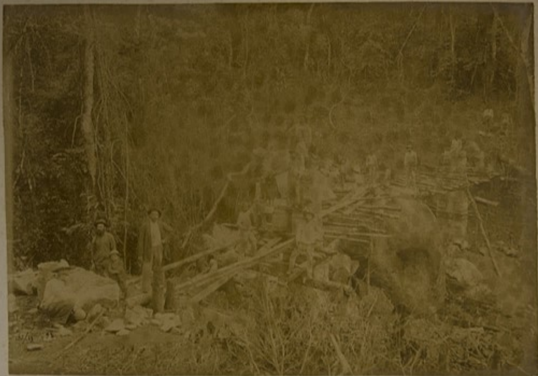
PASSAGEM DO AQUEDUCTO DE S. M. DE SOBRE O CRIQUEIRO DO BUNDO
