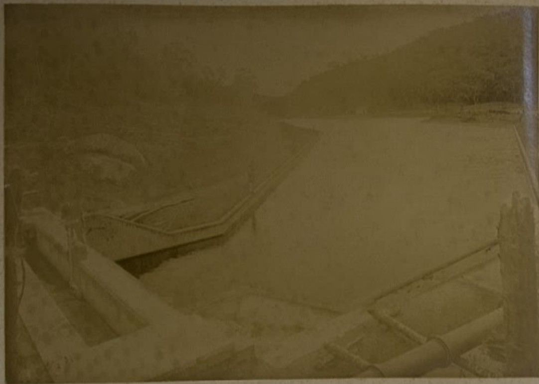
RESERVATÓRIO D' NA ENTRADA DO CASMINUNGA
