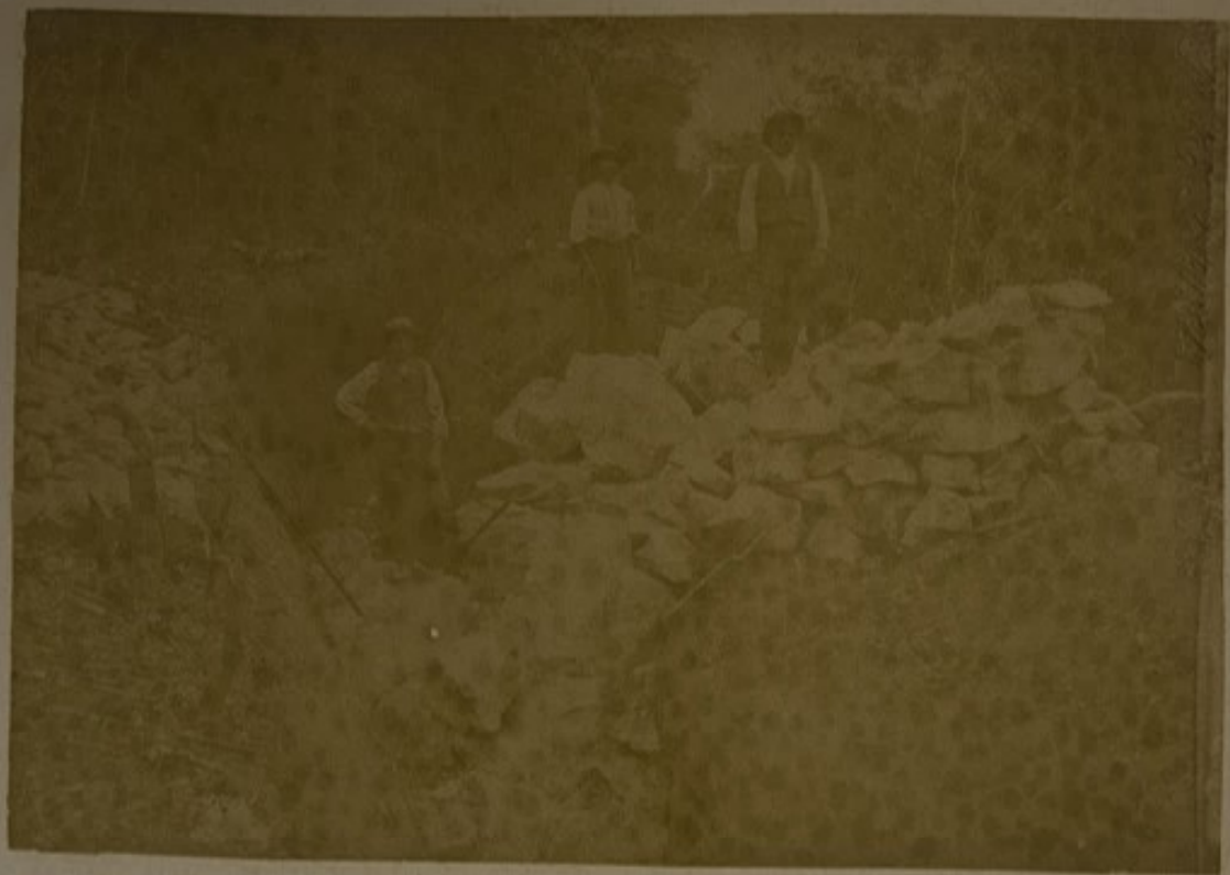
VISTA DA EXCAVAÇÃO ENTRE IRIPO E ITAGUAASI.
