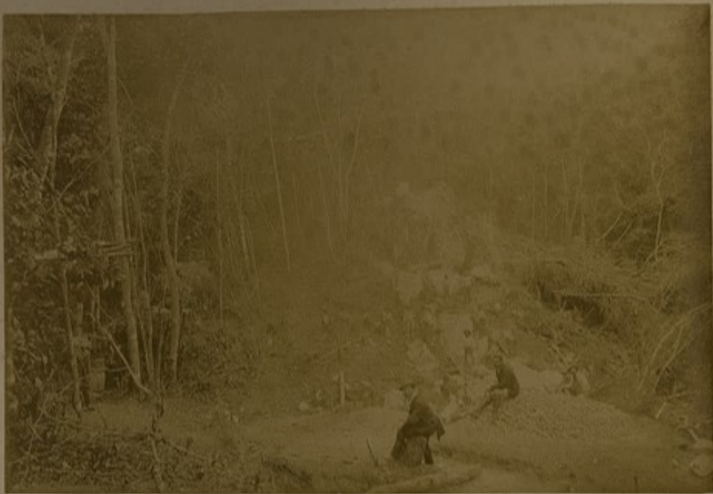
FUNDAÇÕES PARA A PASSAGEM DO AQUEDUCTO DO TANQUE SOBRE O CORREDO DO ALONSO
