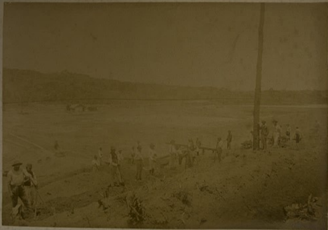
CANALIZAÇÃO DO YRIBANGA — REPRESA PRINCIPAL JUNTO AO LAPEÃO
