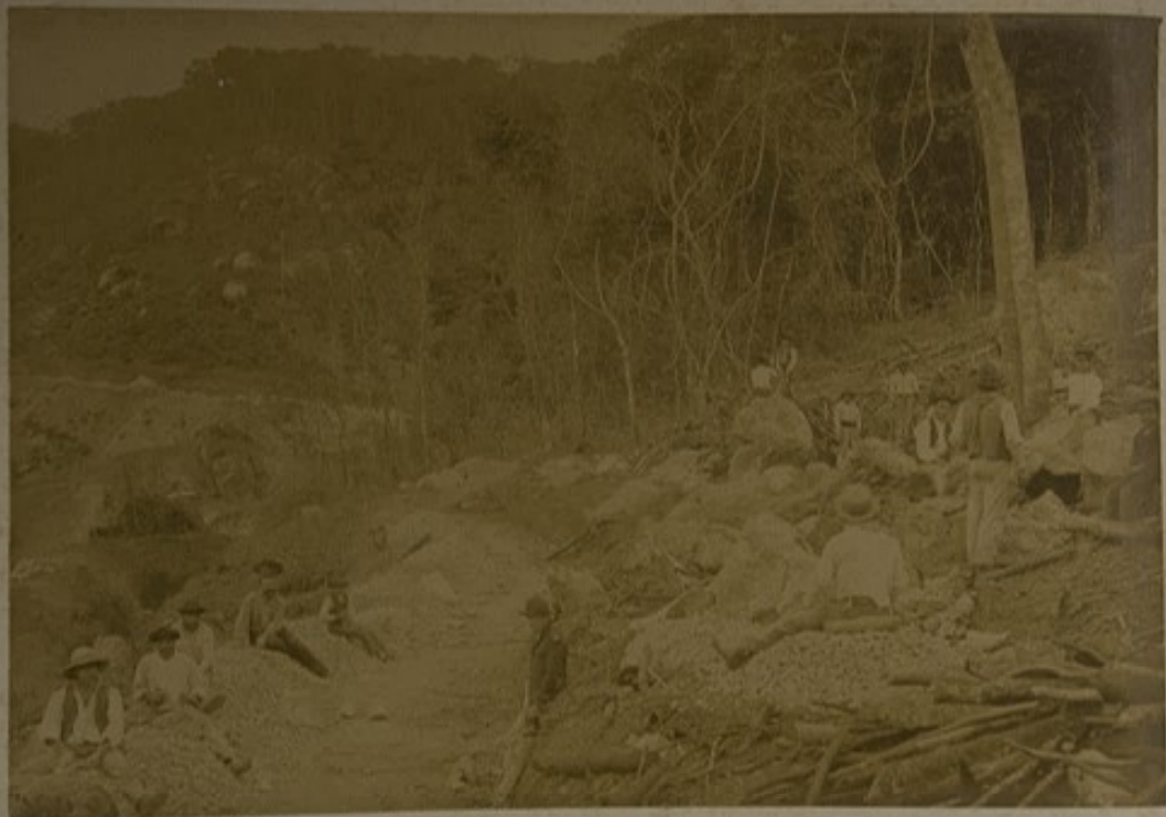
QUEBRAMENTO DE PEDRA PARA O CONCRETO
