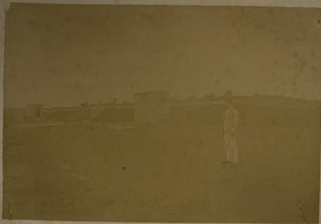
RESERVAÇÃO DA CONSOLAÇÃO
