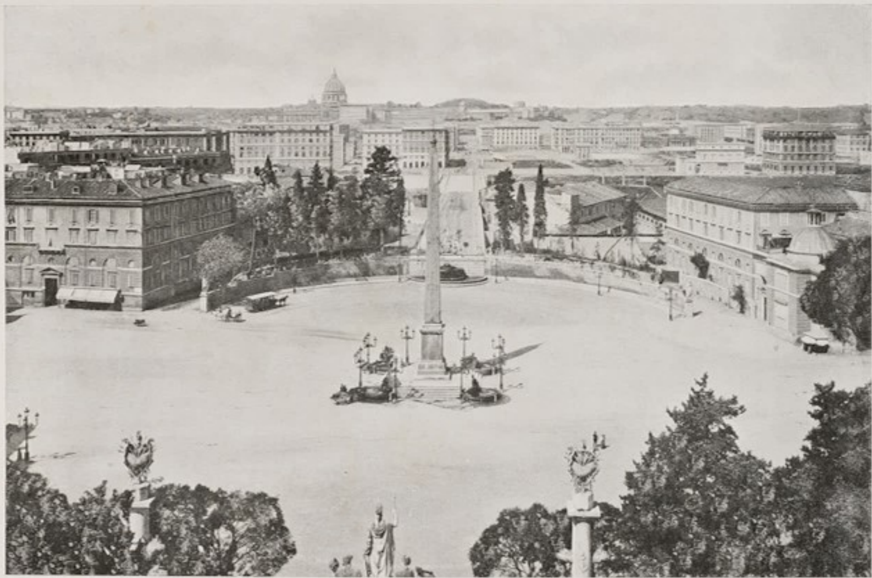
Serie 4530 — ROMA — PIAZZA DEL POPOLO COL NUOVO PONTE MARGHERITA E LE COSTRUZIONI AI PRATI DI CASTELLO.
